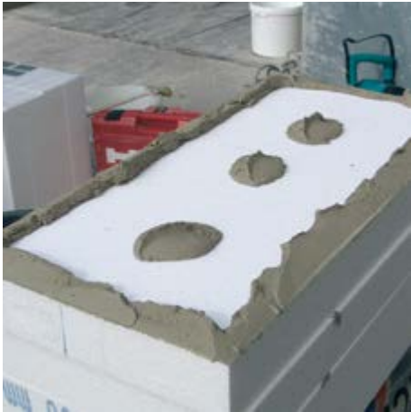
Wulst-Punkt-Verklebung (Bild 1)
